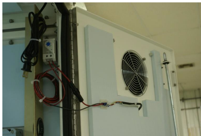
VISTA INTERIOR DEL VENTILADOR DE ESCAPE CON LA PUERTA ABIERTA
